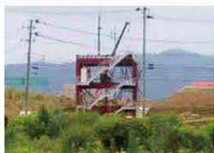
震災遺構となっている旧南三陸防災庁舎
